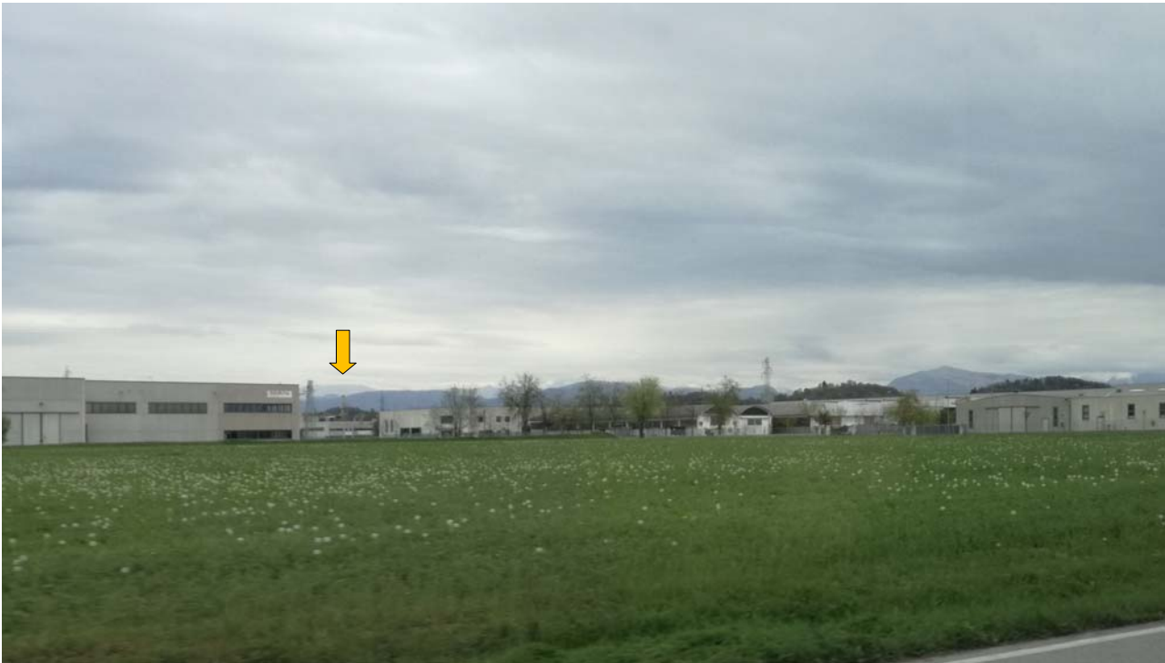
Figura 18 – vista da SP 78 – Via del Torre
