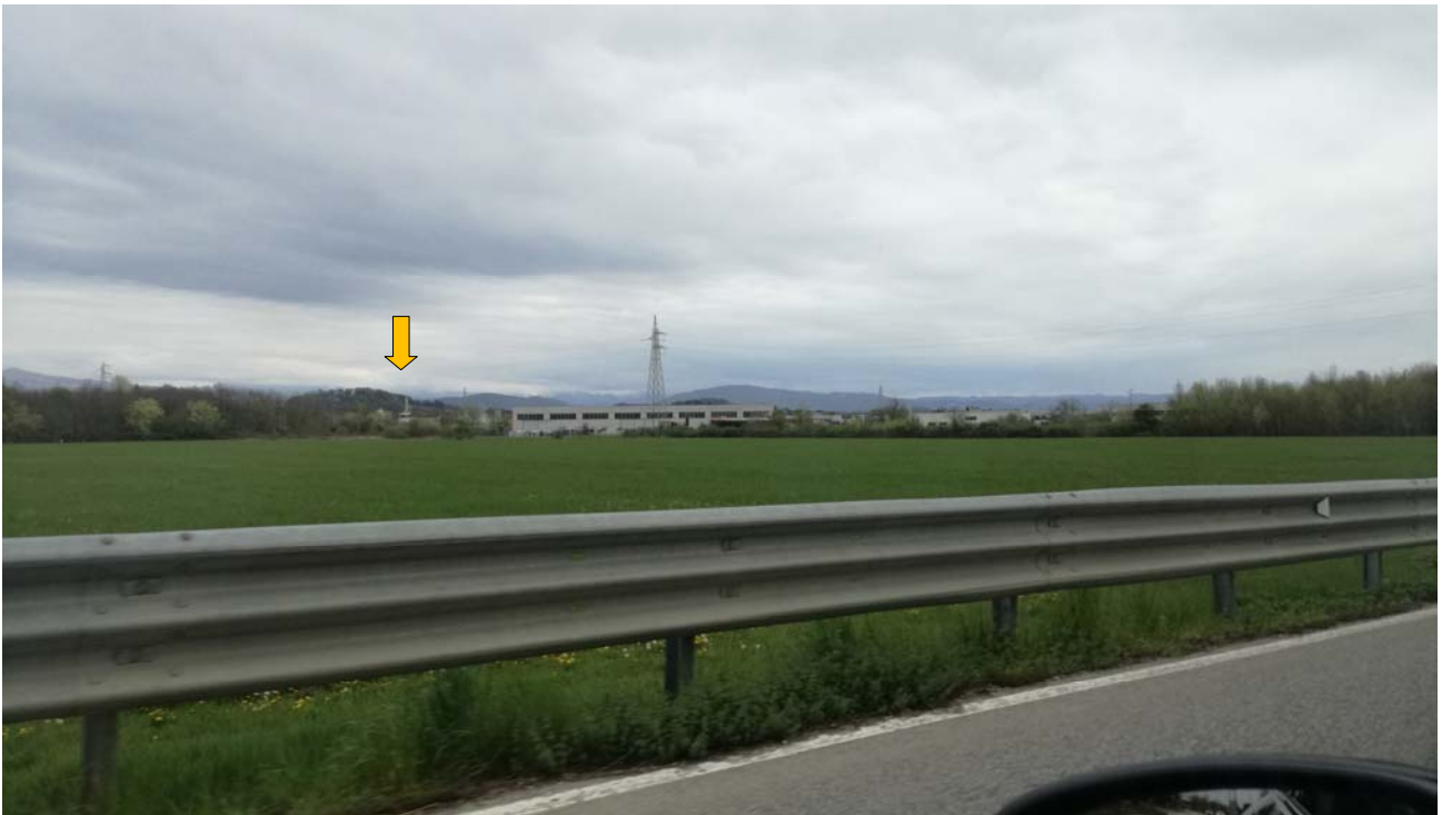
Figura 17 – vista da SP 78 – Via del Torre
